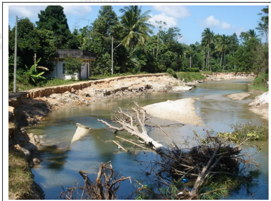
ภาพประกอบ 4-1 สภาพความเสียหายจากการขุดลอกคลอง
